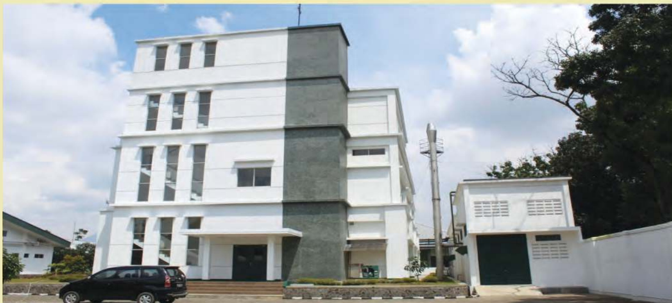
GEDUNG LABIOVAK DITKESAD
