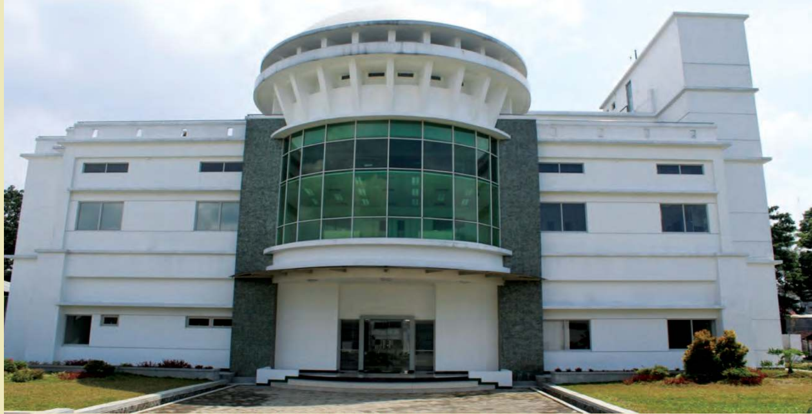
GEDUNG LABIOVAK DITKESAD
