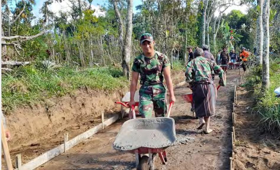
Sasaran fisik sebagai sasaran pokok meliputi pembukaan jalan dengan panjang 850 meter dan lebar 5 meter, pengaspalan jalan dengan panjang 850 meter dan lebar 3 meter, pembuatan 2 buah plat beton dengan panjang 12 meter, lebar 1,5 meter, dan tebal 20 centimeter, pembuatan DPT/Senderan dengan panjang 550 meter dan tinggi rata-rata 1,5 meter, dan rabat beton jalan dengan panjang 2.333 meter, lebar 2,5 meter dan tebal 12 centimeter.
