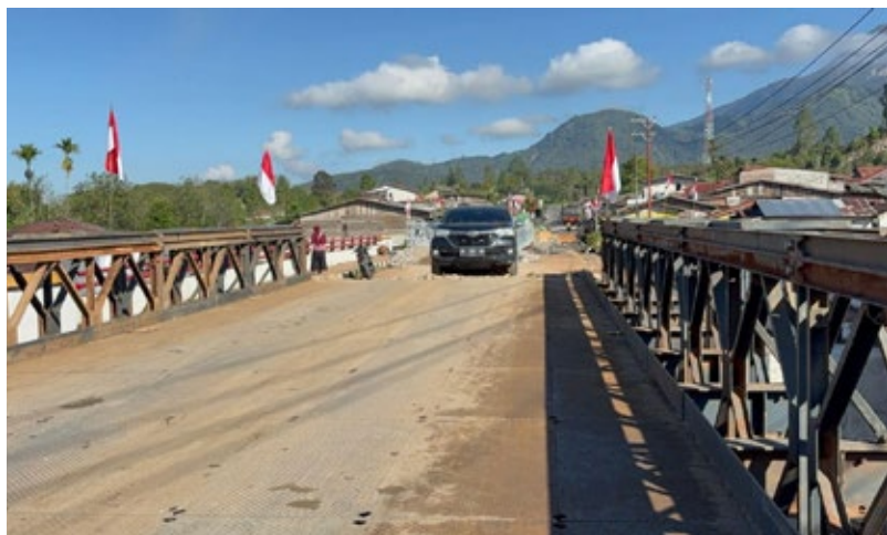
Foto 1.3,dan 1.4. Jembatan Jamur Ujung, Aceh, setelah pemasangan jembatan darurat Bailey.
