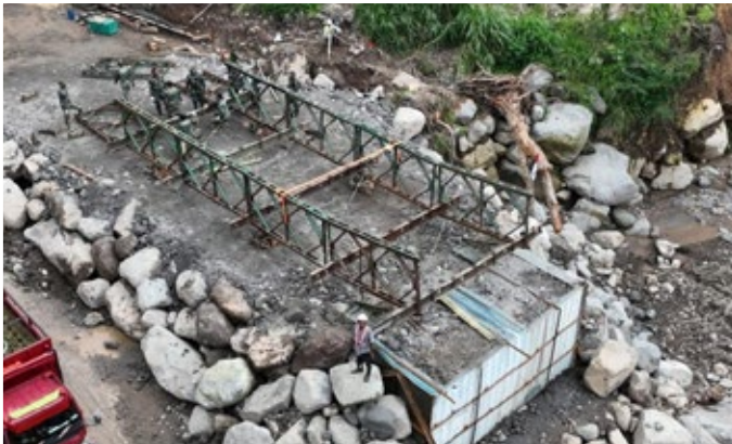
Foto 2.2,dan 2.3. Jembatan Timang Gajah, Sumatera Utara, proses pemasangan jembatan Bailey.
