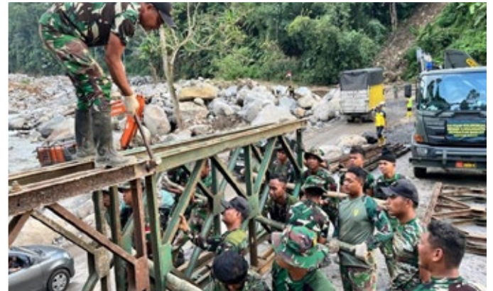
Foto 2.2,dan 2.3. Jembatan Timang Gajah, Sumatera Utara, proses pemasangan jembatan Bailey.
