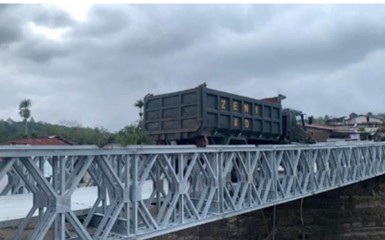
Foto 1.3,dan 1.4. Jembatan Jamur Ujung, Aceh, setelah pemasangan jembatan darurat Bailey.
