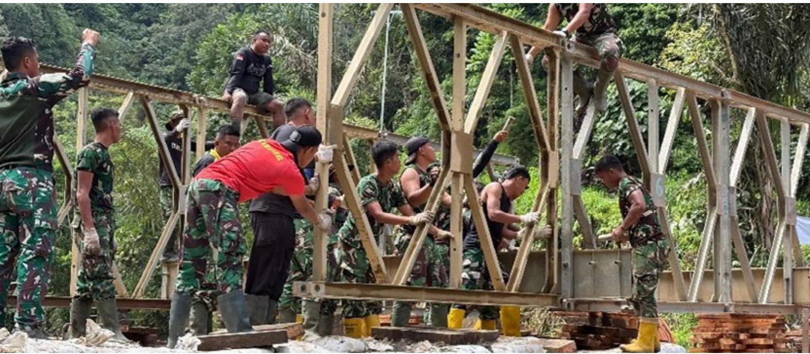
Foto 3.3. Proses pengerjaan Jembatan Aia Taganang, Nagari Matua Hilia, Agam – Sumatera Barat.
