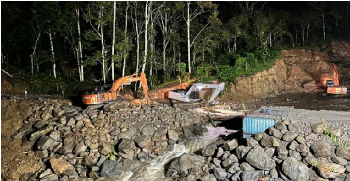
Foto 2.1, Jembatan Timang Gajah, Sumatera Utara, sebelum pemasangan jembatan Bailey.
