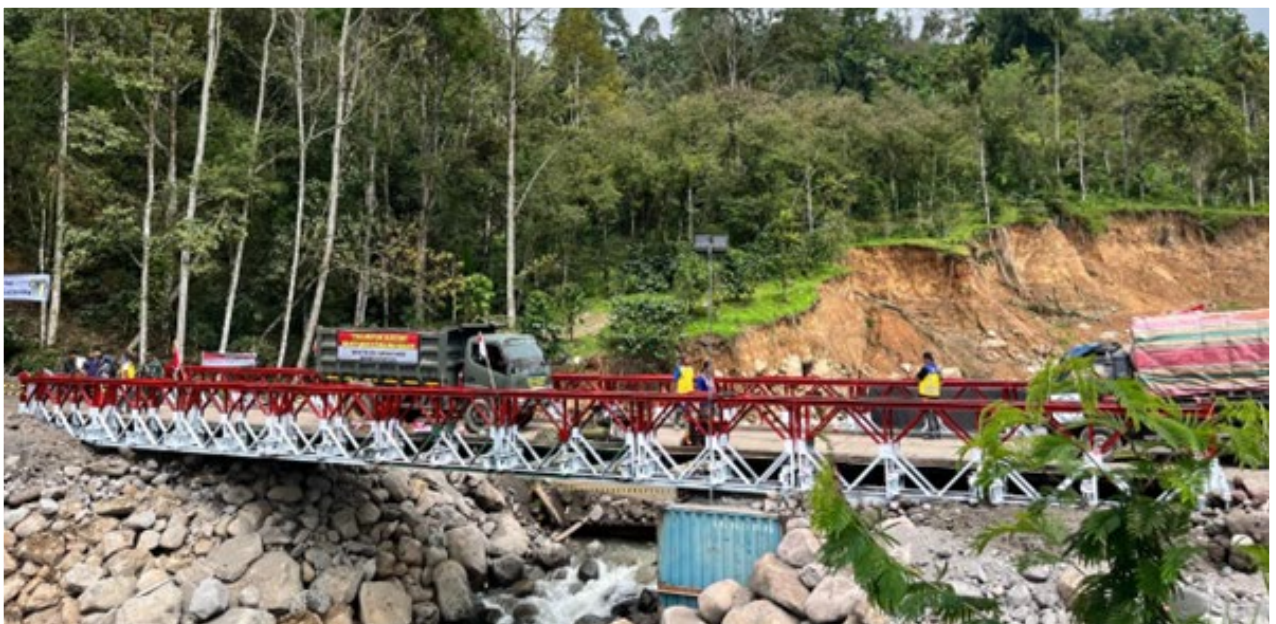
Foto 2.4, Jembatan Timang Gajah, Sumatera Utara, setelah pemasangan jembatan Bailey.
