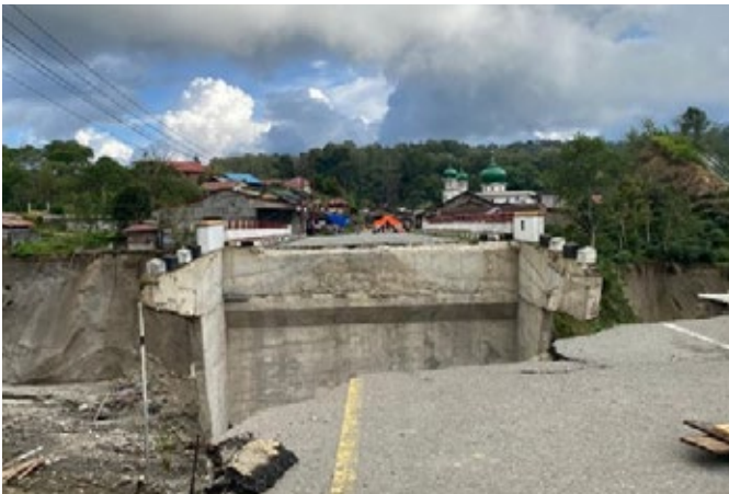
Foto 1.1,dan 1.2. Kondisi awal Jembatan Jamur Ujung, Aceh, setelah bencana.
